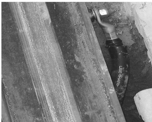
Questo dispositivo può essere composto, per esempio, da una piastrina saldata sull'elemento da collegare. Il cavo di collegamento termina con un capocorda, fissato a sua volta sulla piastrina mediante una vite. Il cavo di collegamento è rivestito di isolante e passa attraverso una guaina (v. foto).
